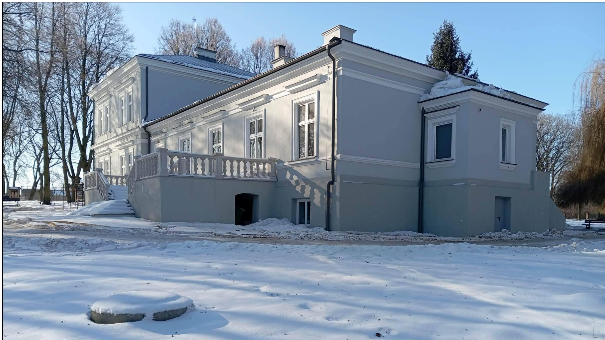
Widok na elewację tylną i szczytową – północną
