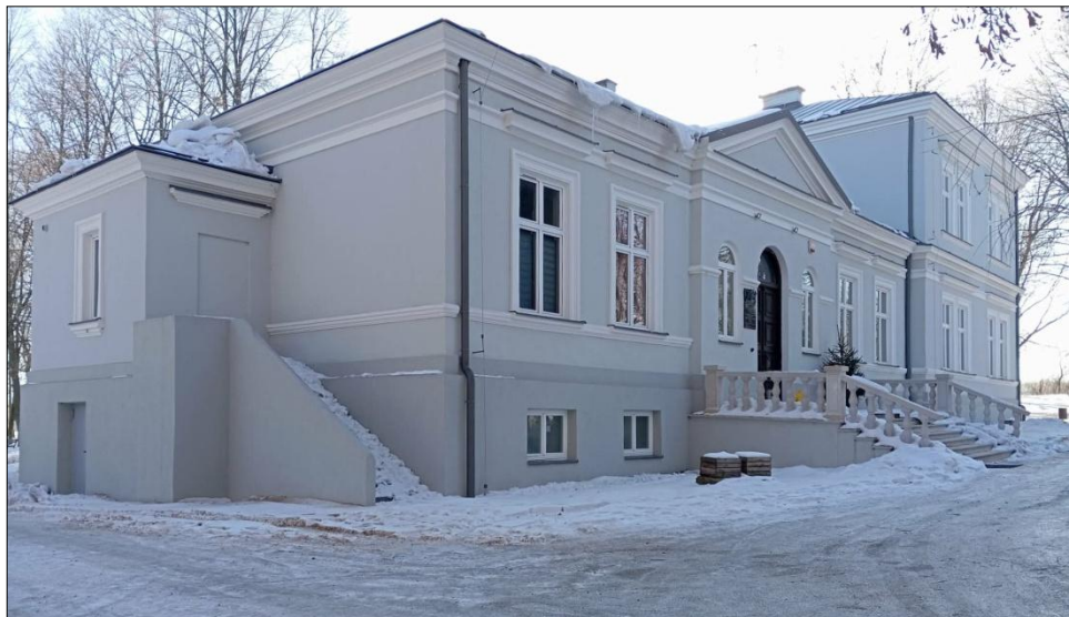
Widok na fasadę i elewację szczytową – północną
