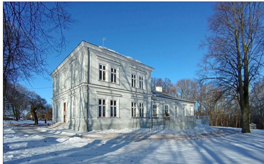
Widok na elewację tylną i elewację szczytową – południową
